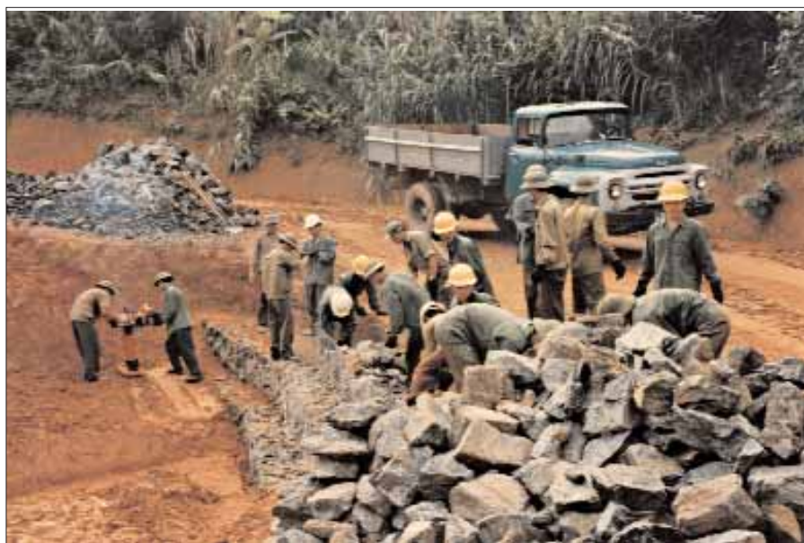
Lính thợ Trường Sơn kè đường chống sự tử tại Nghĩa trang
